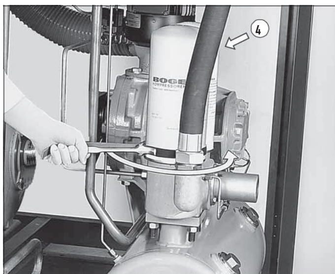
Рис. 6.6: Замена маслосепараторов
